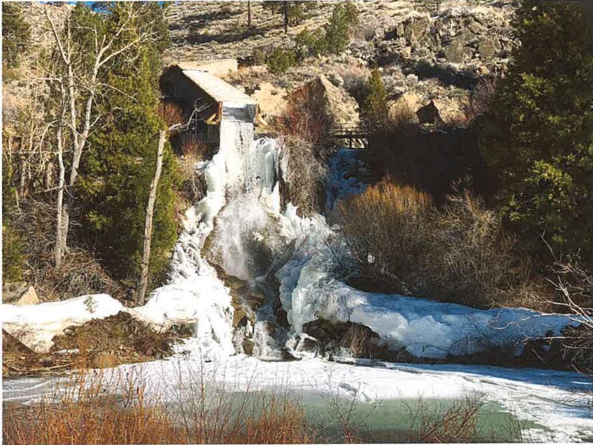
Photo: Fleish Hydro Forebay Spill
